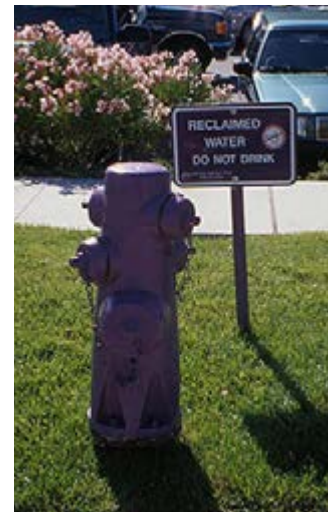
En la actualidad, la mayoría de los céspedes regados con agua reciclada crecen en campos de golf, campos deportivos y parques. Sin embargo, el riego con agua reciclada está aumentando en otros espacios urbanos comunes.
